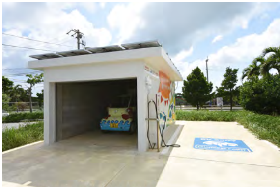
写真3 エコステーション（宮古島市）
